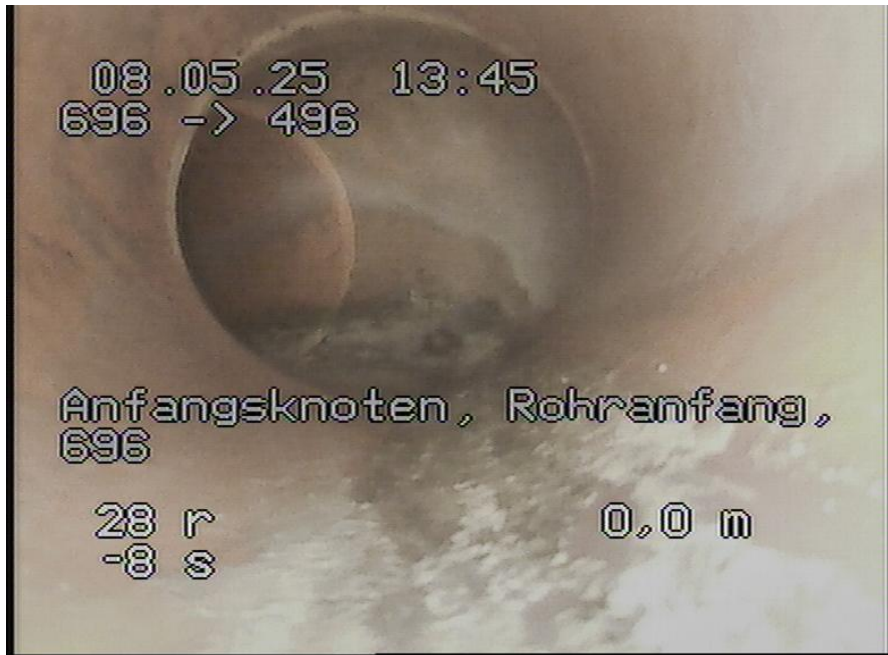
696-496_657.jpg, 00:00:00, 0.00m Anfangsknoten, Rohranfang, 696
