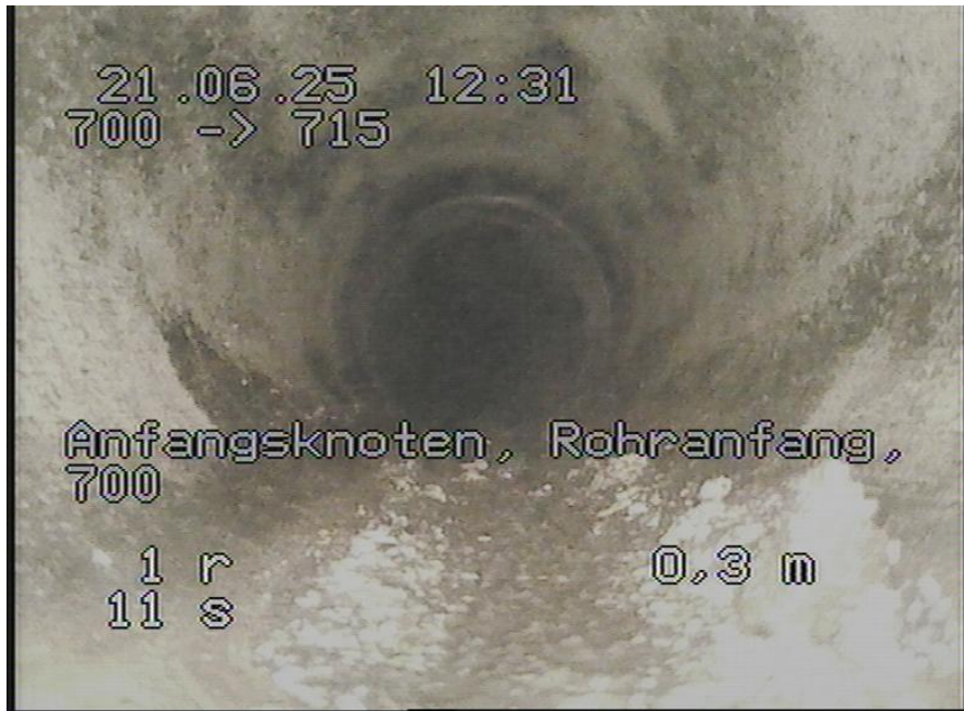
700-715_761.jpg, 00:00:00, 0.00m Anfangsknoten, Rohranfang, 700
