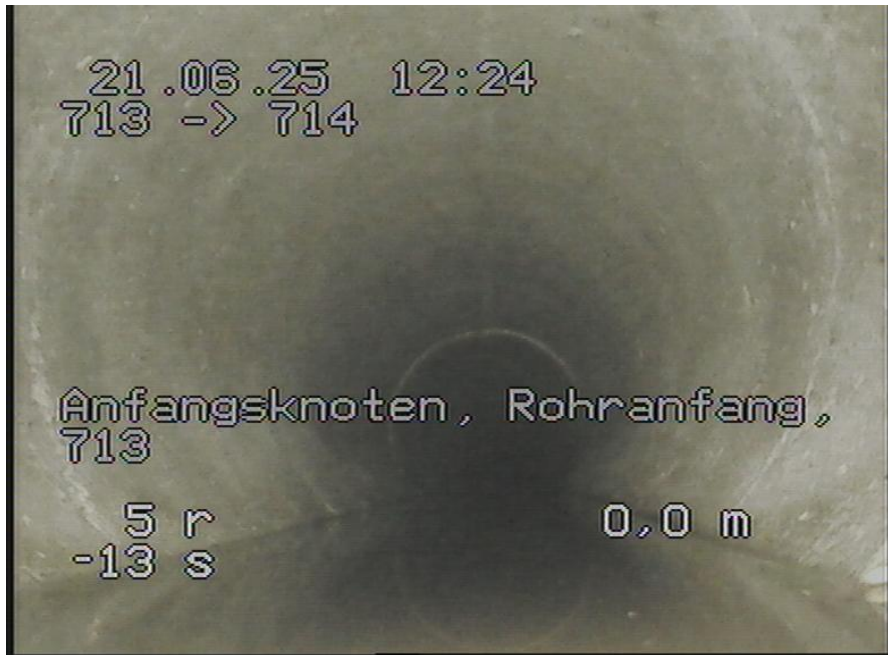
713-714_759.jpg, 00:00:00, 0.00m Anfangsknoten, Rohranfang, 713
