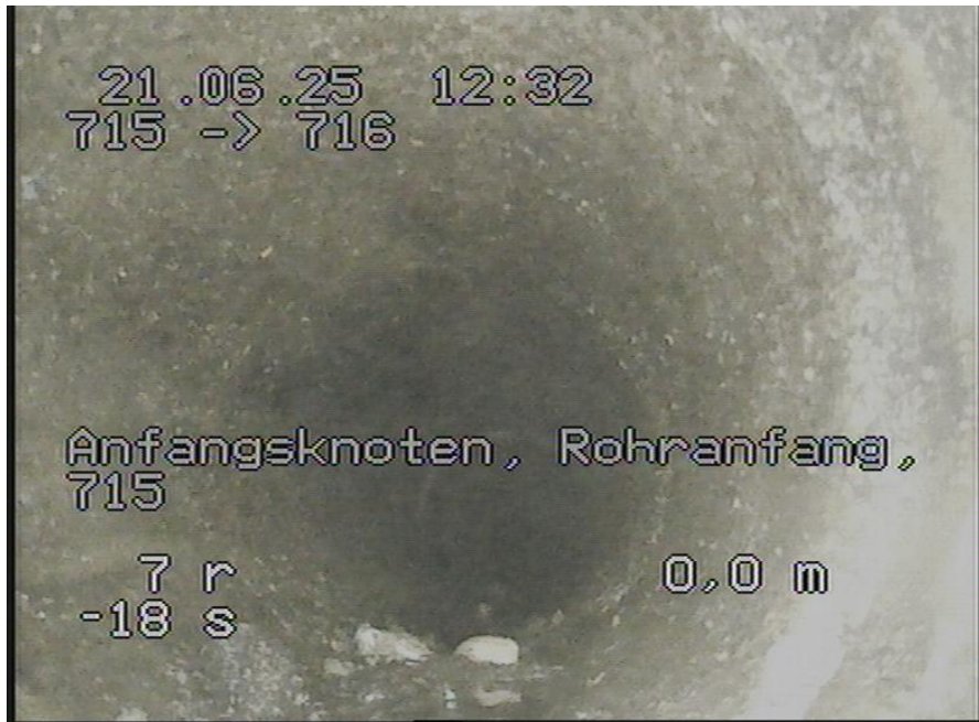
715-716_763.jpg, 00:00:00, 0.00m Anfangsknoten, Rohranfang, 715
