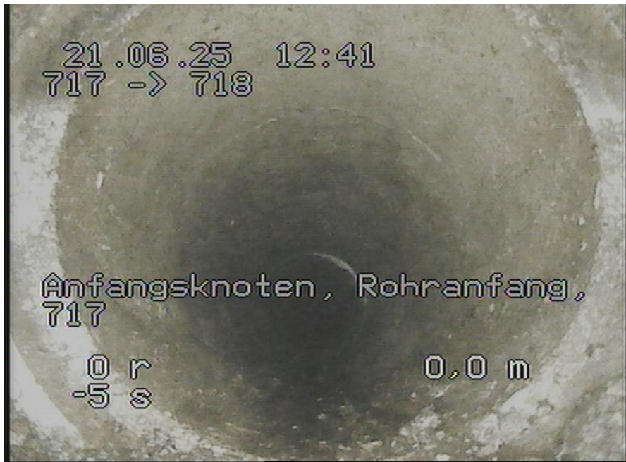
717-718_768.jpg, 00:00:00, 0.00m Anfangsknoten, Rohranfang, 717
