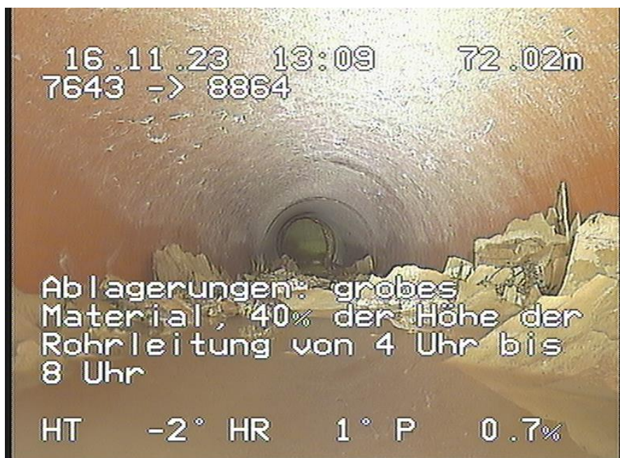
7643-8864_231116_130422_0472.jpg, 00:04:59, 72.02m Ablagerungen: grobes Material, 40% der Höhe der Rohrleitung von 4 Uhr bis 8 Uhr
