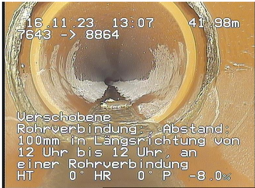
7643-8864_231116_130422_0471.jpg, 00:03:19, 41.98m Verschoebene Rohrverbindung: Abstand: 100mm in Längsrichtung von 12 Uhr bis 12 Uhr, an einer Rohrverbindung
